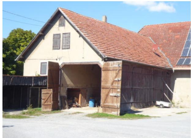
Abb. 6: Gebäude B aus Südosten mit Dachüberständen an Giebel- und Traufseiten.
