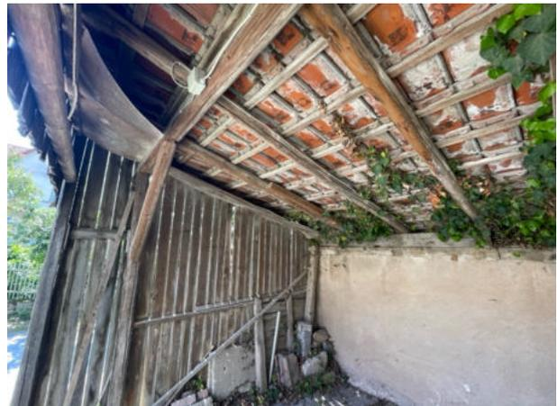
Abb. 4: Dachunterseite des Anbaus A ohne freitragende Dachbalken oder sicheren Nischen.
