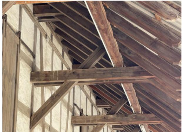
Abb. 20: Westseite von Gebäudeteil D mit freitragenden Dachbalken und Spalten.
