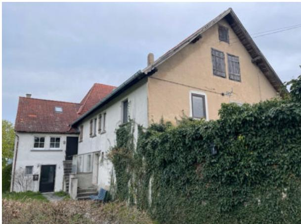
Abb. 5: Gebäude B aus Südwesten mit Dachüberständen an Giebel- und Traufseiten.
