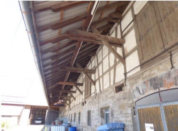
Abb. 19: Westseite von Gebäudeteil D mit freitragenden Dachbalken und Spalten.
