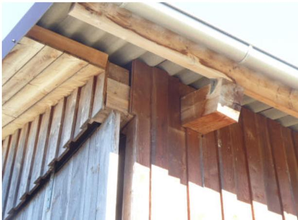
Abb. 34: Lücken zwischen Dach und Außenwand an Gebäude G.
