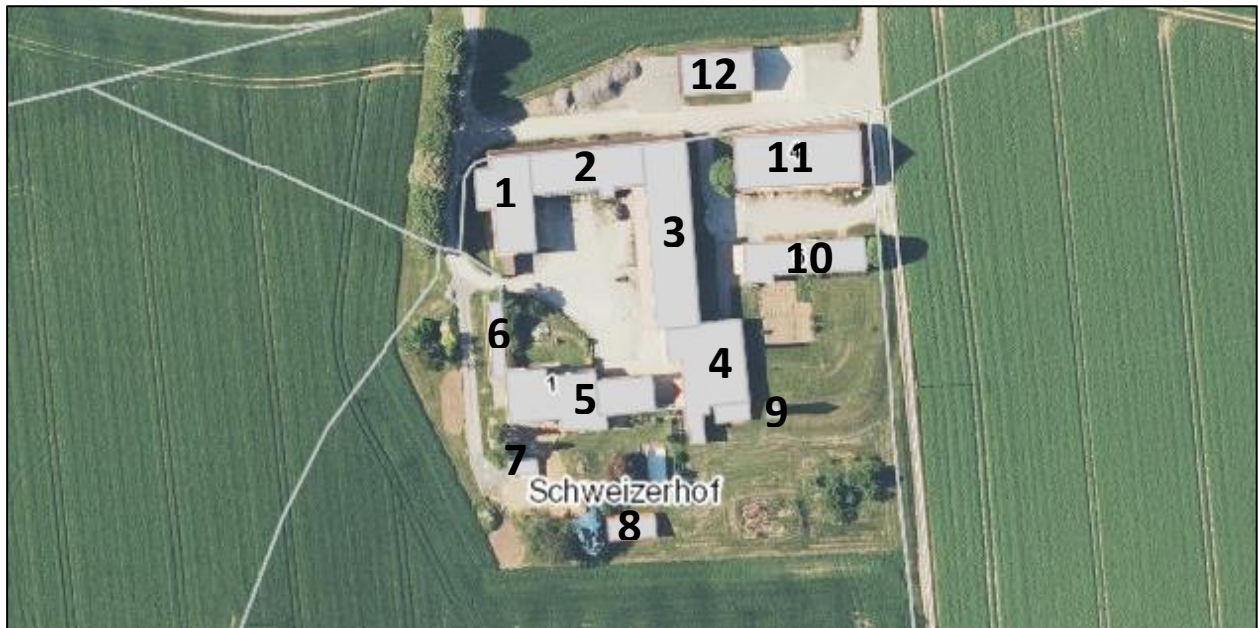
Abbildung 2: Luftbild des Gutshofs „Schweizerhof“ und Nummerierung der Bestandsgebäude 2
